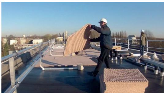
Matériel: tapis en mousse de polyuréthane recyclé avec pores ouverts
